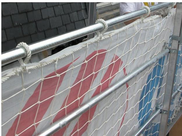
Die Belagtafeln, Abschlussleisten, Leisten und Netze werden auf den Konsolen und Schutzgeländern installiert, um die Arbeit auf dem Gerüst zu sichern.
